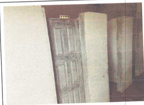
FOTO Nº BANHEIROS 15 PINTAR PAREDES E ESQUADRIAS
