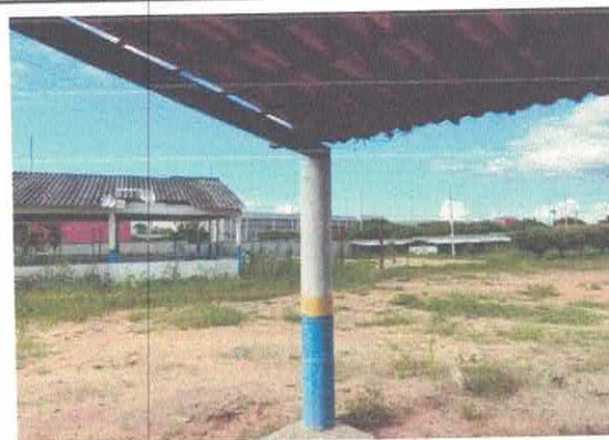
FOTO Nº GALPÃO 01 6 RETELAMENTO E PINTURA
