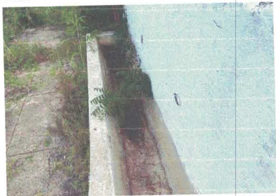
FOTO Nº 11 BEBEDOURO PARA ANIMAIS IMPERMEABILIZAR
