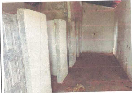
FOTO Nº BANHEIROS 14 PINTAR PAREDES E ESQUADRIAS
