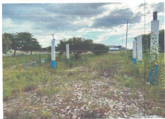
FOTO Nº ENTRADA PARA EXPOSIÇÃO 1 ROÇO, CAPINA E PILARES
