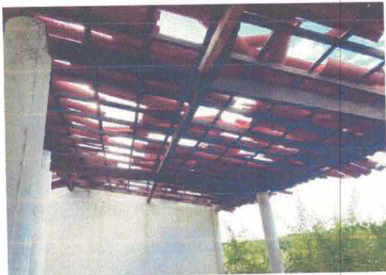
FOTO Nº 9 GALPÃO 01 RETELAMENTO E PINTURA
