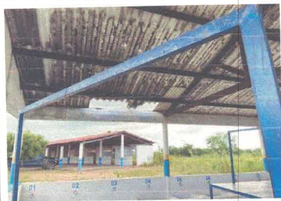
FOTO Nº GALPÃO 01 5 RETELAMENTO E PINTURA
