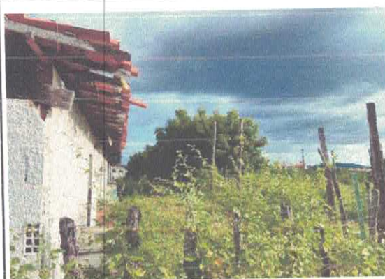
FOTO Nº 12 BARES RETELHAR, PINTAR E CONSTRUIR UM MURO
