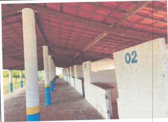
FOTO Nº BARES 13 RETELHAR, PINTAR E CONSTRUIR UM MURO
