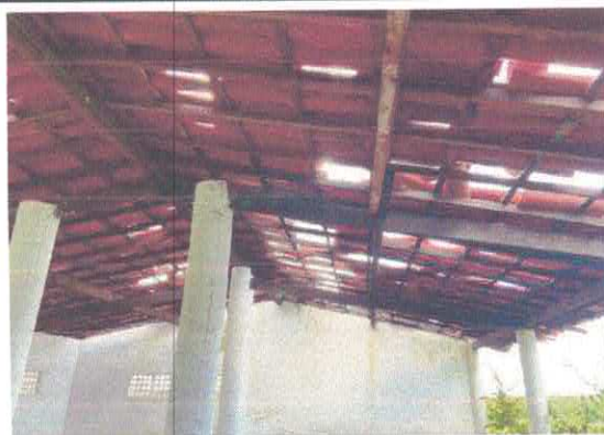
FOTO Nº 8 GALPÃO 01 RETELAMENTO E PINTURA
