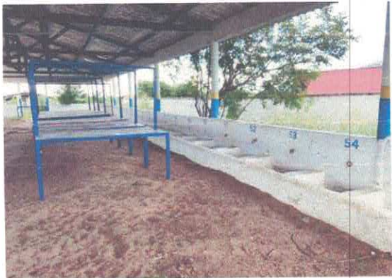
FOTO Nº 7 GALPÃO 01 RETELAMENTO E PINTURA
