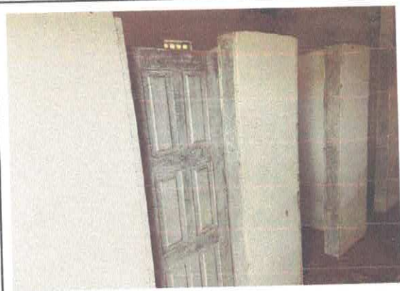
FOTO Nº 15 BANHEIROS PINTAR PAREDES E ESQUADRIAS
