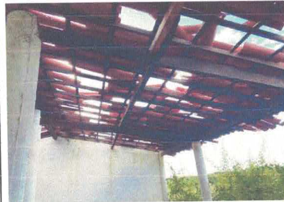
FOTO Nº GALPÃO 01 9 RETELAMENTO E PINTURA
