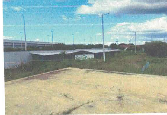
FOTO Nº CHIQUEIROS 4 RECUPERAR MADEIRAMENTO E RETELAMENTO
