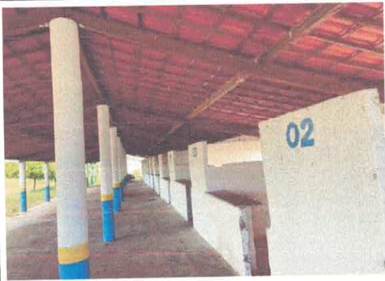
FOTO Nº 13 BARES RETELHAR, PINTAR E CONSTRUIR UM MURO
