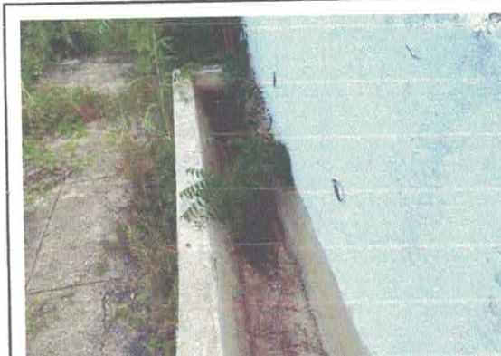
FOTO Nº BEBEDOURO PARA ANIMAIS 11 IMPERMEABILIZAR
