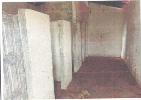
FOTO Nº 14 BANHEIROS PINTAR PAREDES E ESQUADRIAS
