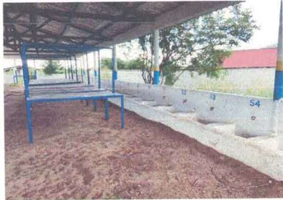
FOTO Nº GALPÃO 01 7 RETELAMENTO E PINTURA
