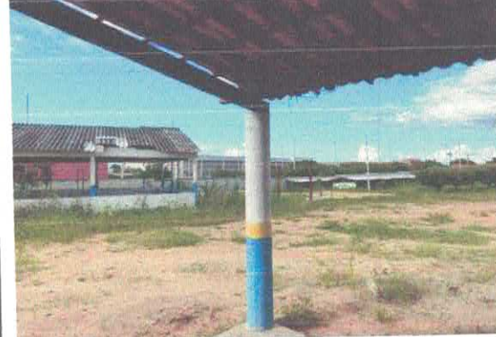
FOTO Nº GALPÃO 01 6 RETELAMENTO E PINTURA
