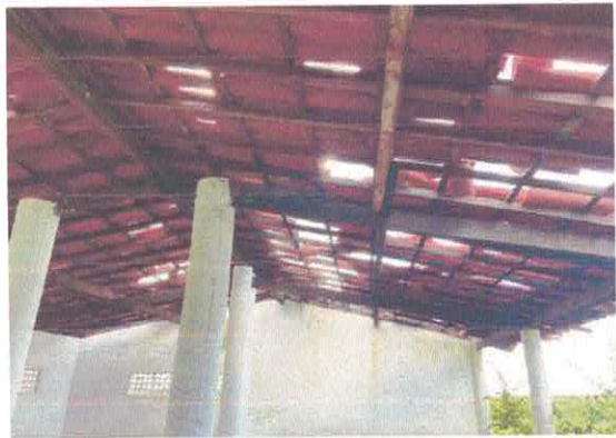
FOTO Nº GALPÃO 01 8 RETELAMENTO E PINTURA
