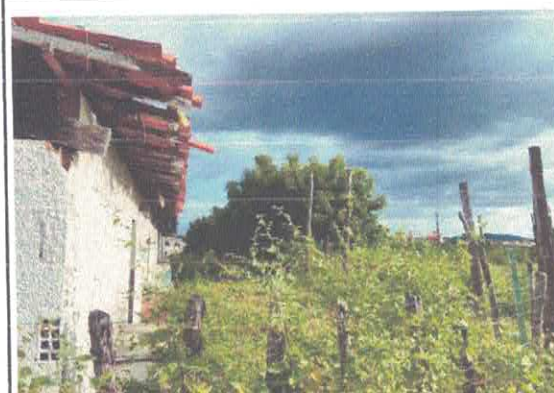
FOTO Nº BARES 12 RETELHAR, PINTAR E CONSTRUIR UM MURO
