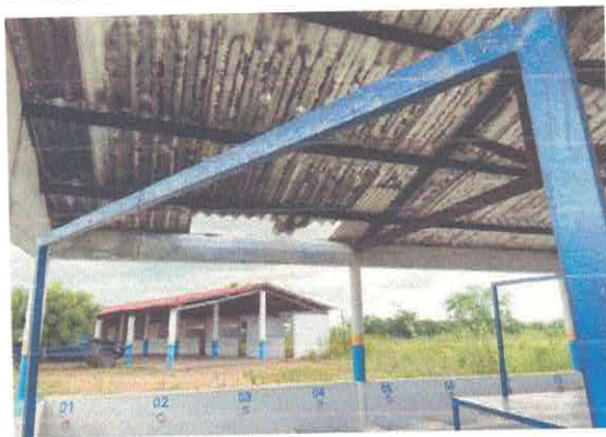
FOTO Nº GALPÃO 01 5 RETELAMENTO E PINTURA
